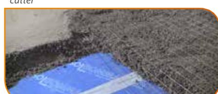
Prevedere se necessario l'armatura del massetto in fase di getto
