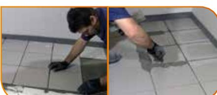
Posare la pavimentazione ed eseguire la fugatura delle piastrelle
